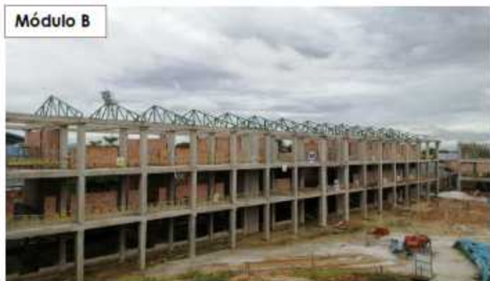
Tijerales metálicos (3er piso).
