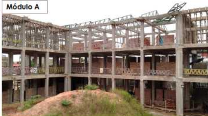
Tijerales Metálicos (3er piso).
